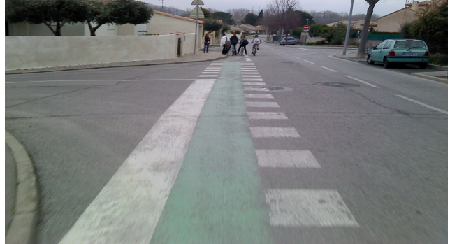
revêtement vert très glissant par temps de pluie (photo:SIX Gabriel )
